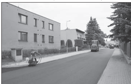
Dokončování prací ve Spojovací (foto V. Kozel)
