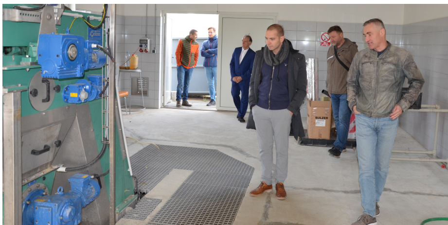
Prohlídka nové ČOV
