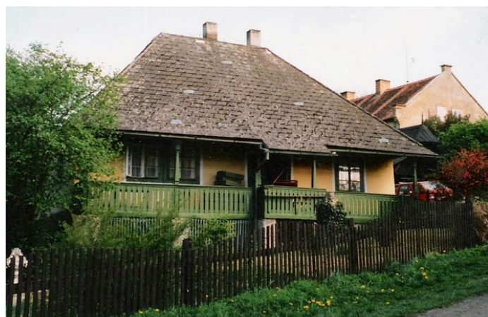
„Laubovna“ – stav před požárem v roce 1996
