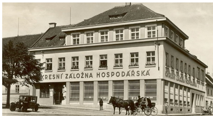
Novostavba Okresní hospodářské záložny
