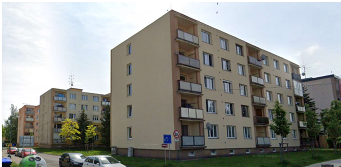
Obr. 11: Fotografie objektů typu B
