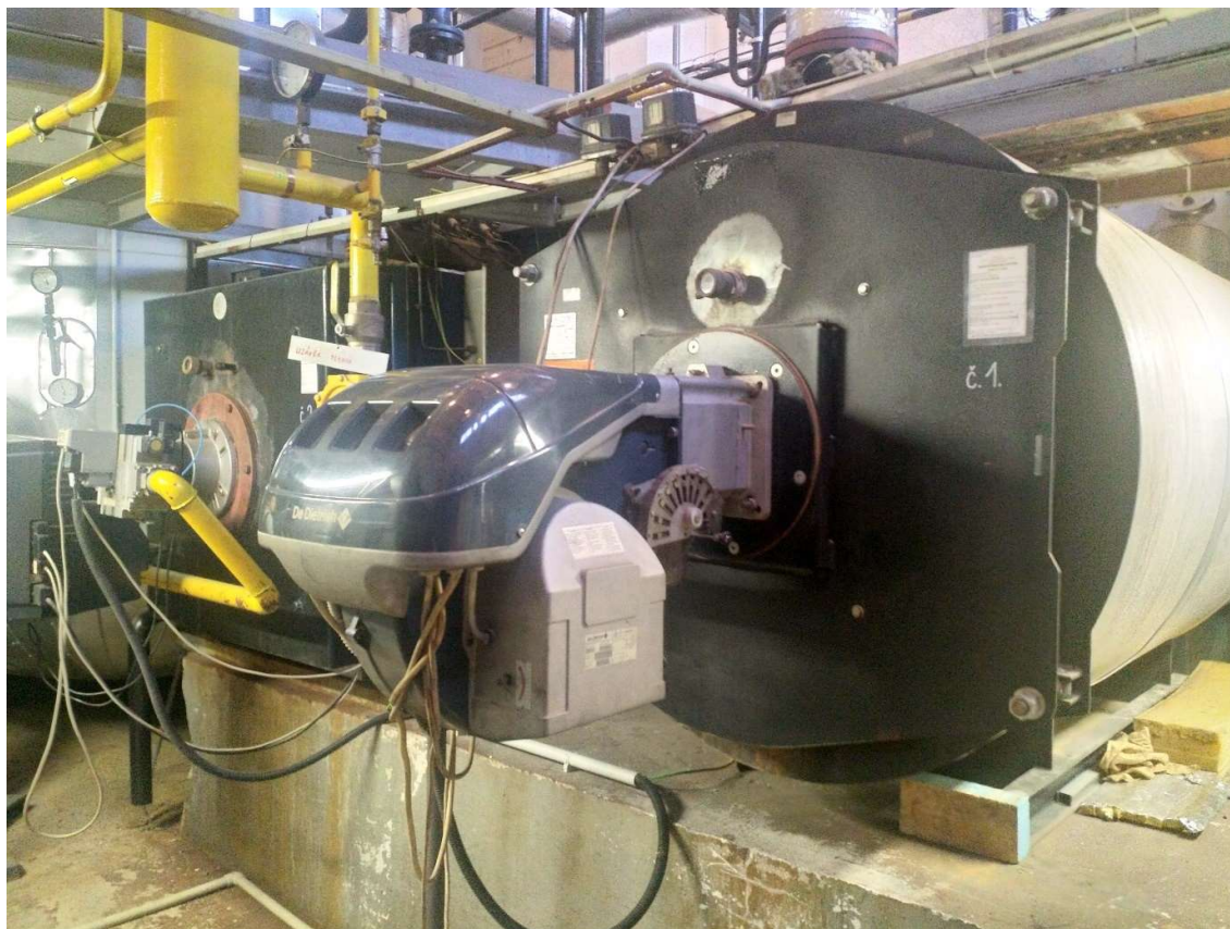
Obr. 2: Fotografie interiéru kotelný Topinkova, pohled na kotle ČKD Dukla a YGNIS.
