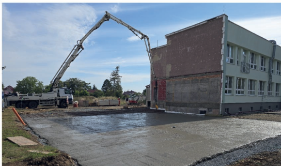
Stavební práce u mateřské školky
