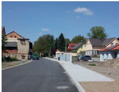
Foto po rekonstrukci
