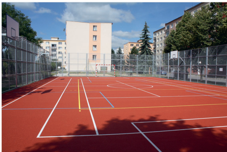
Výstavba hřiště v Křivoklátském sídlišti
