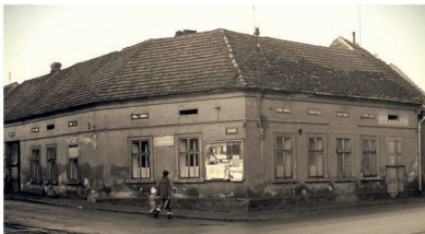
Bývalý hostinec U Kochmanů před demolicí
