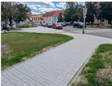
Opravený chodník na Komenského náměstí
