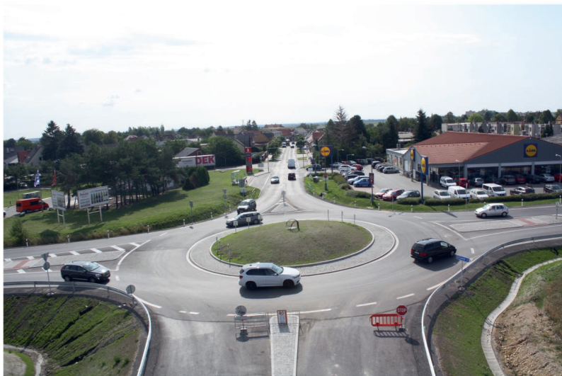
Stavba kruhového objezdu
