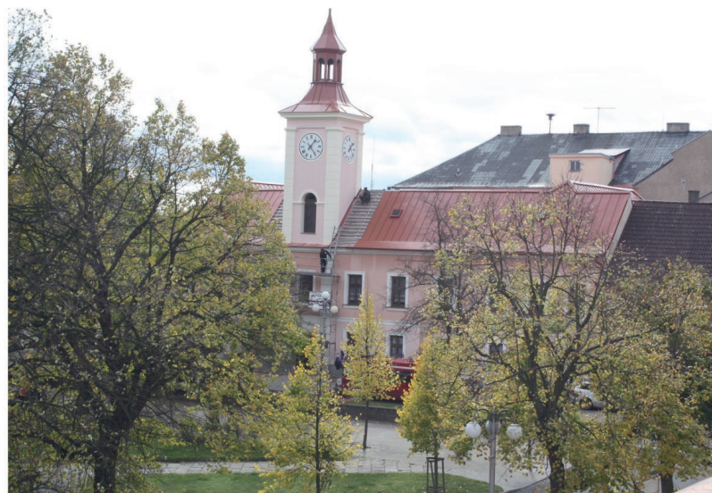
Rekonstrukce věže na budově „Lidušky“
